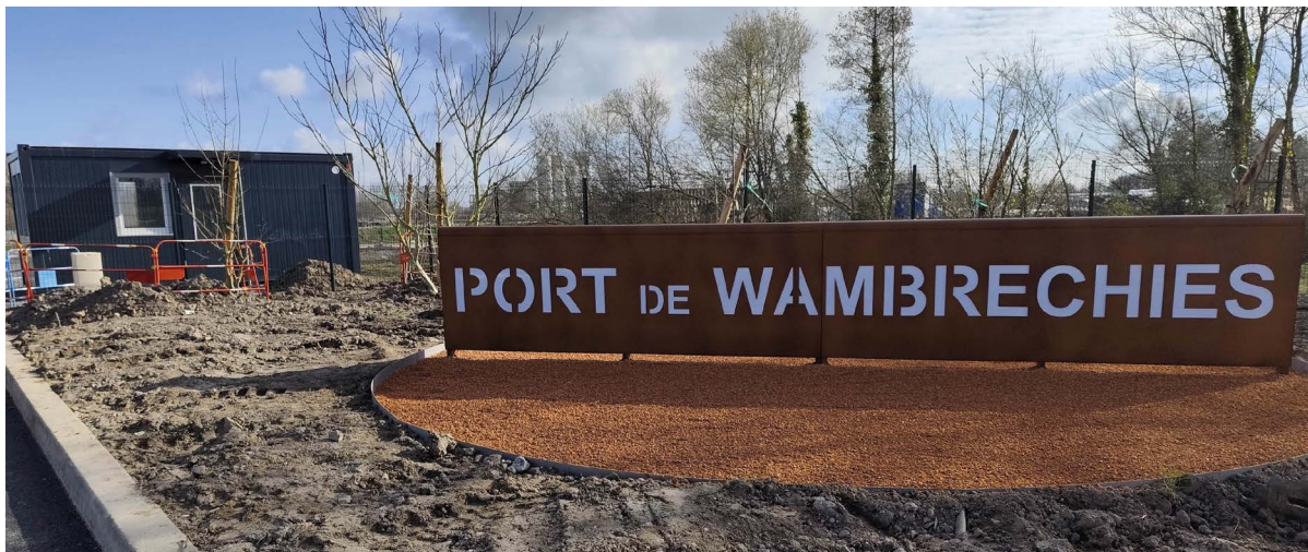
Nouvel accès poids lourds, port de Wambrechies.
