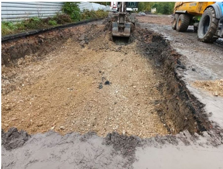
Figure 42 : Photographie des terrassements de la zone X9/X10
