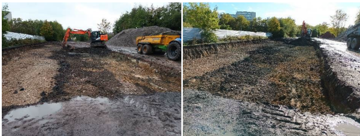
Figure 45 : Photographies des terrassements de la zone X9/X10
