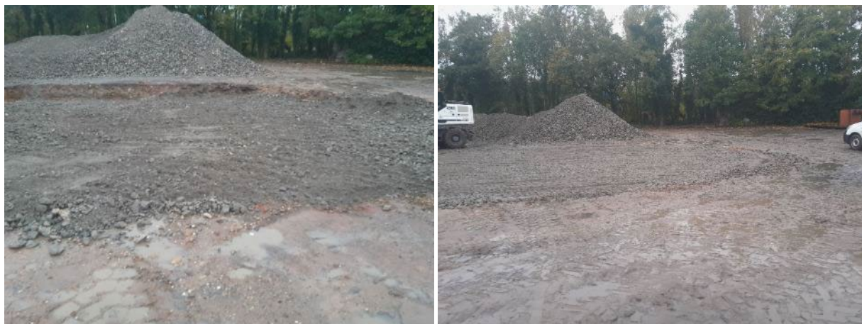
Figure 30 : Photographies du remblaiement et du compactage des matériaux concassés au droit de la fouille PPL4
