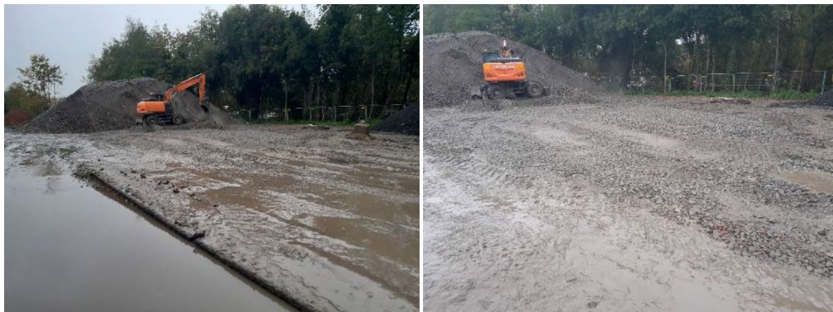
Figure 48 : Photographies du remblaiement et du compactage de matériaux concassés au droit de la fouille X6
