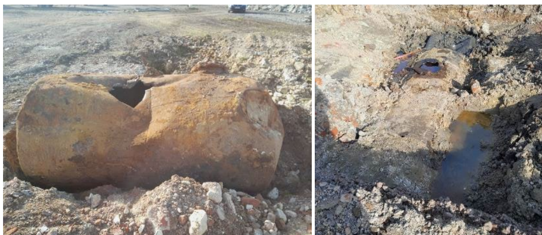
Figure 12 : Photographies de l'ouverture des cuves avant vidange
