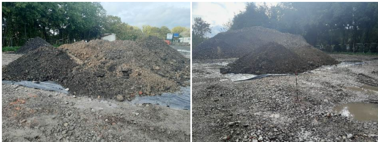
Figure 32 : Photographies des terres excavées issues de la zone polluée X1
