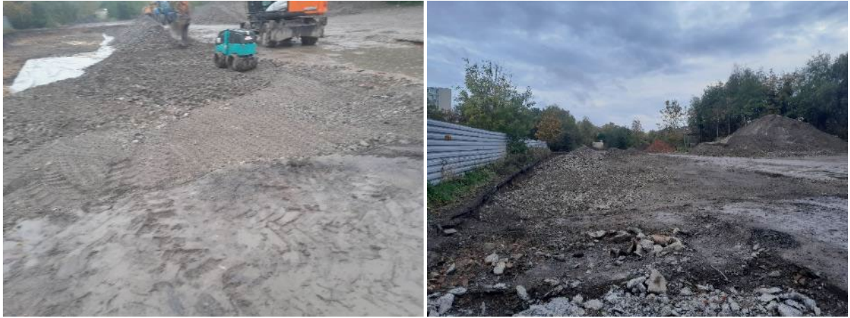
Figure 50 : Photographies du remblaiement et du compactage des matériaux concassés au droit de la fouille X9/X10
