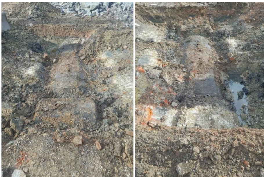
Figure 4 : Photographies des deux cuves au droit la fouille S6
