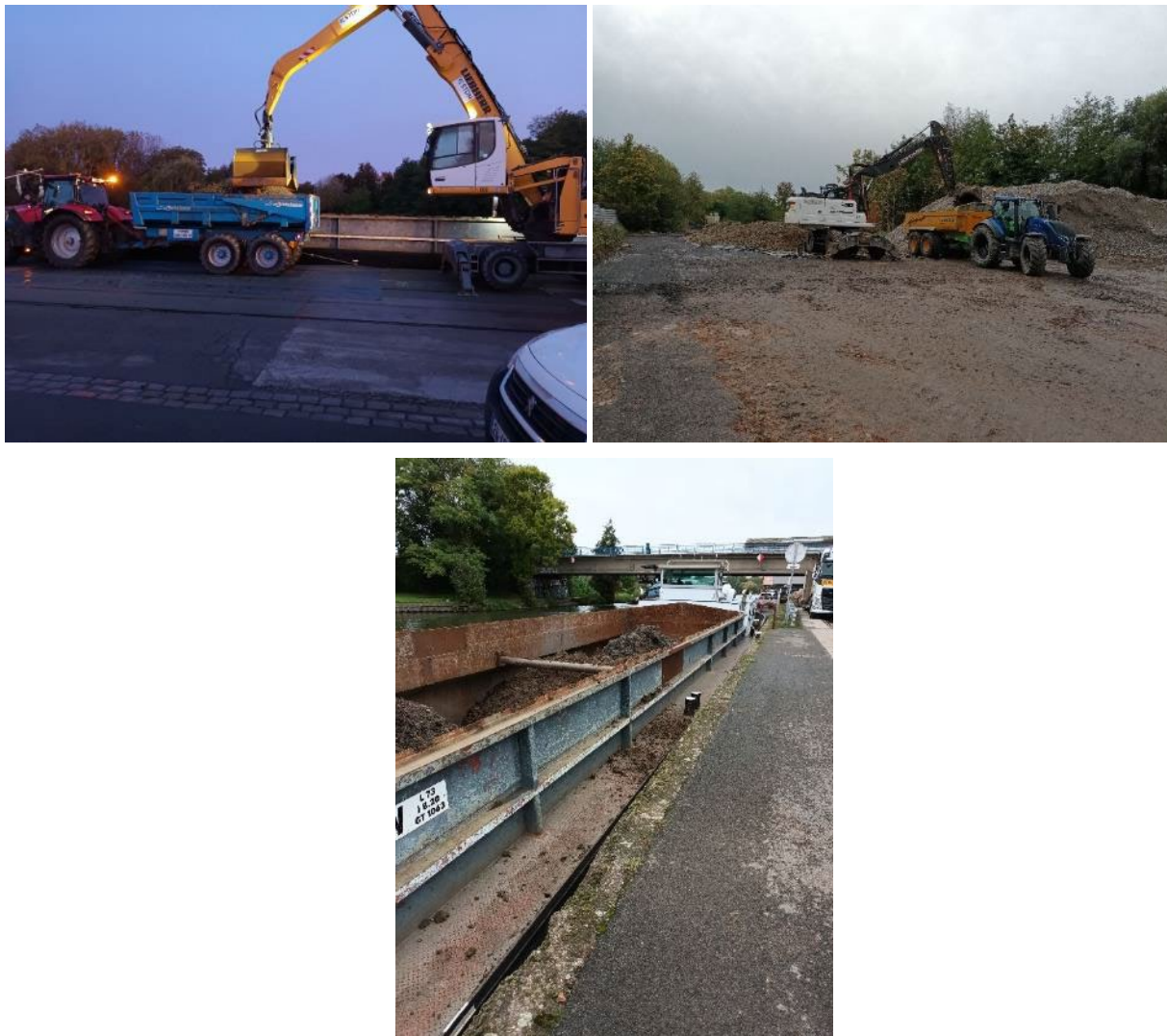
Figure 35 : Photographies des évacuation des déblais pollués (23/10/23)
