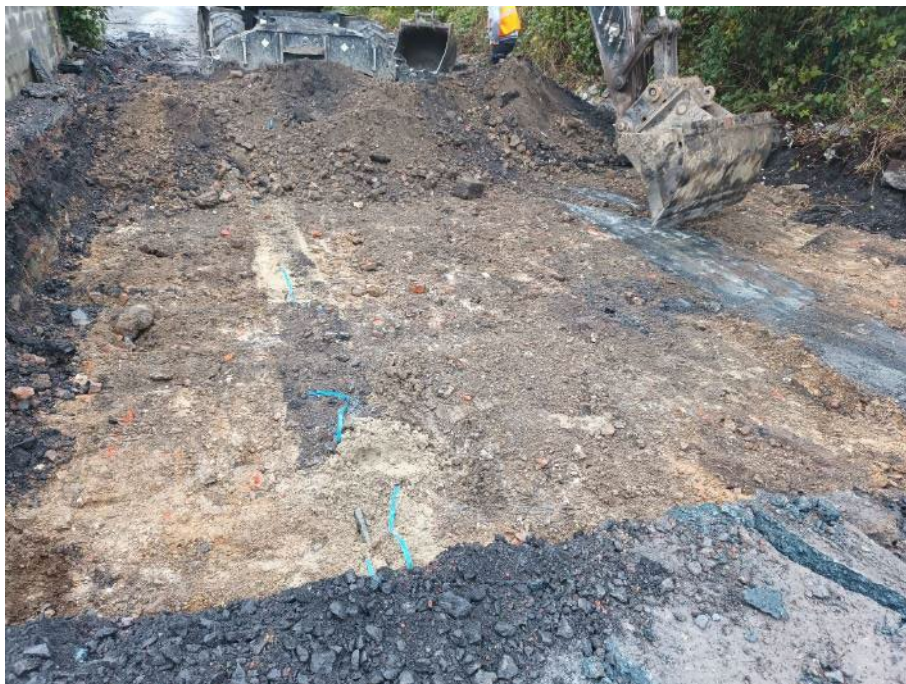
Figure 36 : Photographie de la zone MAR3 en cours de terrassement
