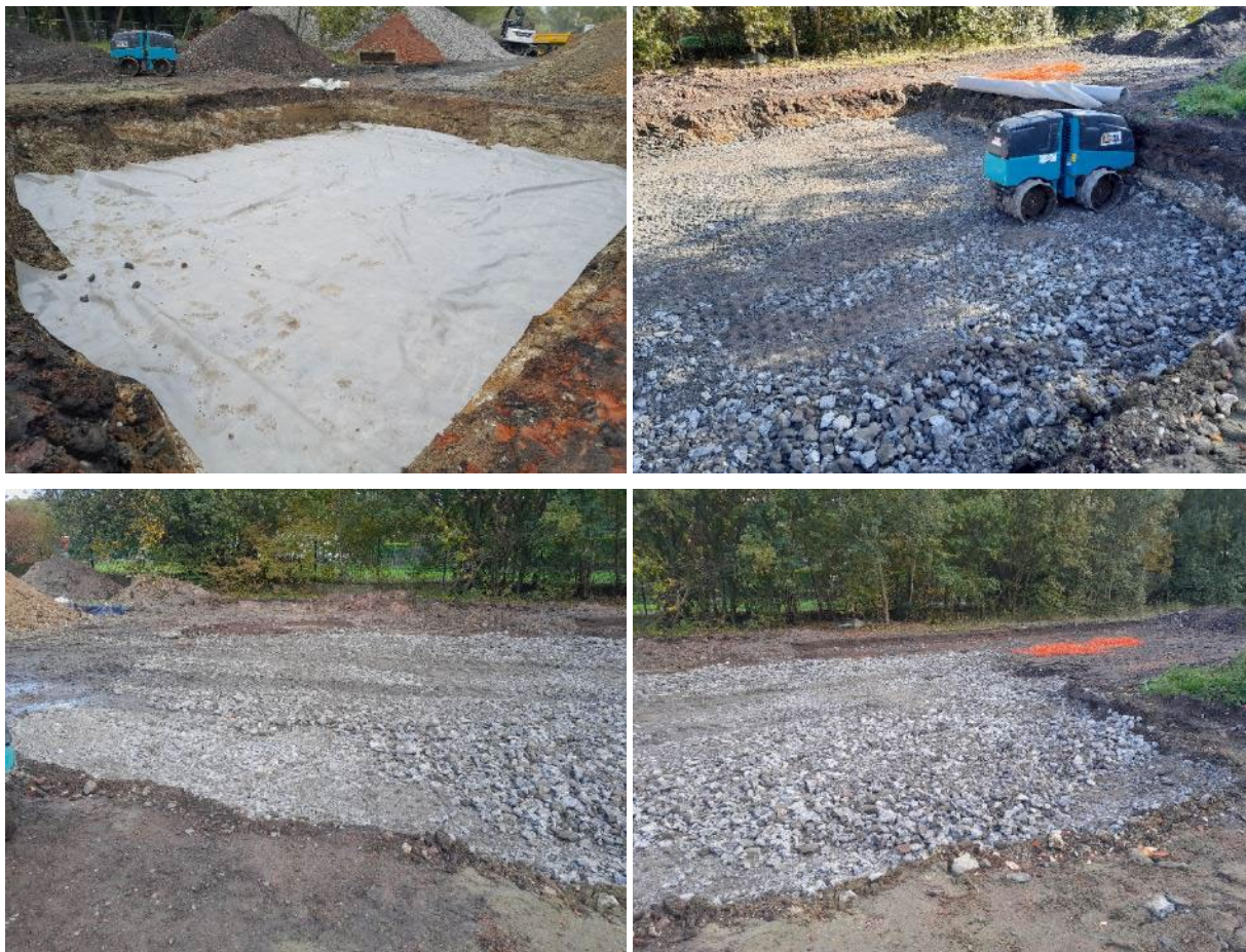
Figure 26 : Photographies du comblement par des matériaux concassés de la fouille MAR7
