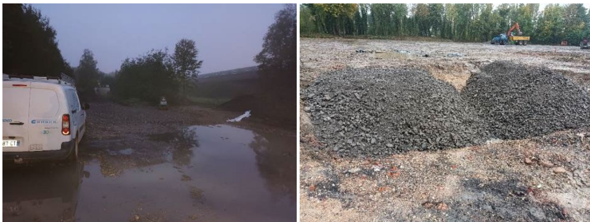
Figure 44 : Photographies du remblaiement des fouilles MAR7 (à gauche) et S6 (à droite)
