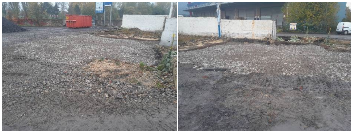
Figure 49 : Photographies de la fouille X1 remblayée et compactée par des matériaux concassés
