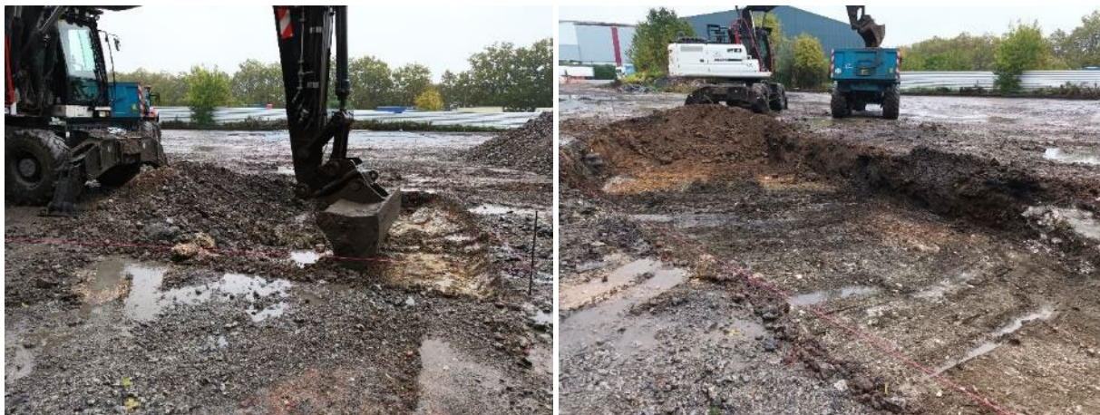
Figure 38 : Photographies de la zone X6 en cours de terrassement
