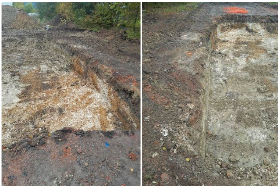
Figure 25 : Photographies de l'élargissement sur la partie Est de la zone MAR7
