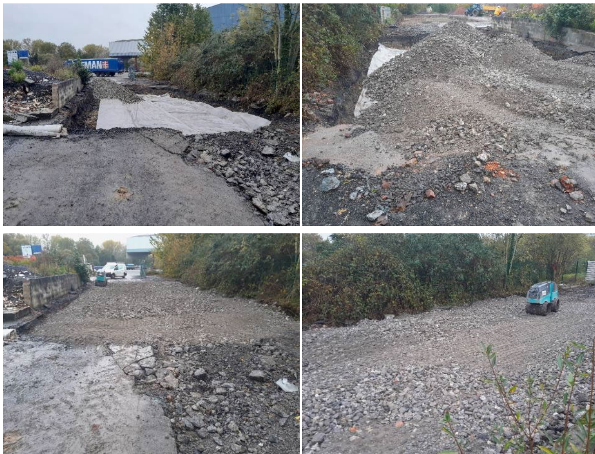
Figure 47 : Photographies du remblaiement et du compactage de matériaux concassés au droit de la fouille MAR3
