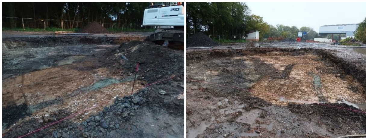
Figure 40 : Photographies des terrassements de la zone X6
