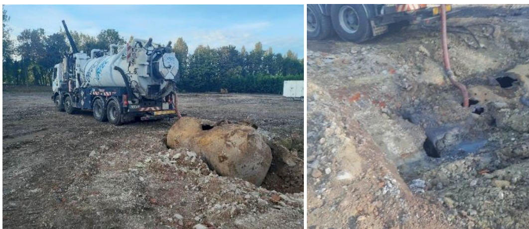
Figure 17 : Photographies du pompage par hydrocureur des cuves
