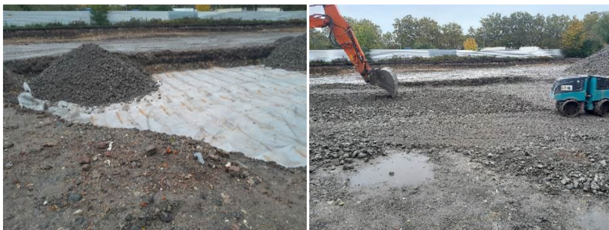
Figure 47 : Photographies du remblaiement et du compactage de matériaux concassés au droit de la fouille MAR3
