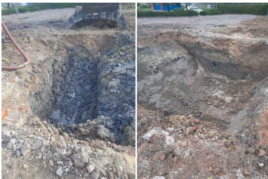
Figure 19 : Photographies des terrassements de la zone S6 après l'enlèvement des cuves
