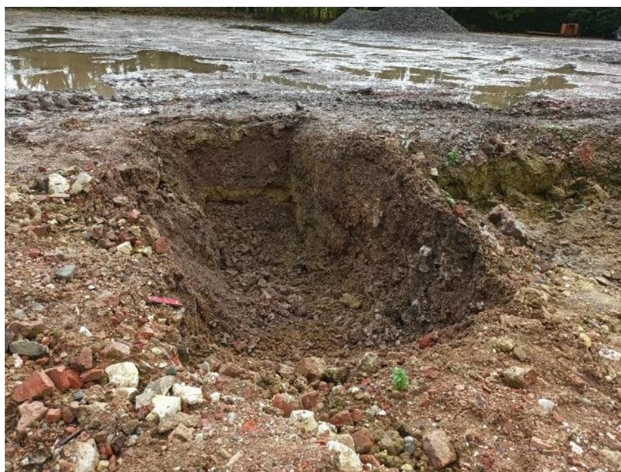
Figure 29 : Photographie du terrassement réalisé au droit de l'ancienne cuve seule
