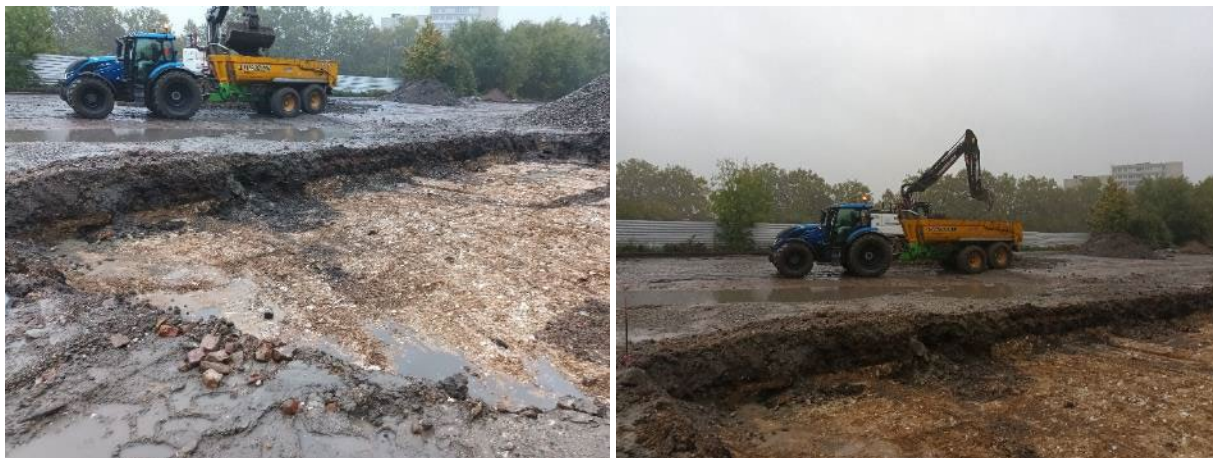
Figure 41 : Photographies du transfert des déblais pollués vers le quai de chargement
