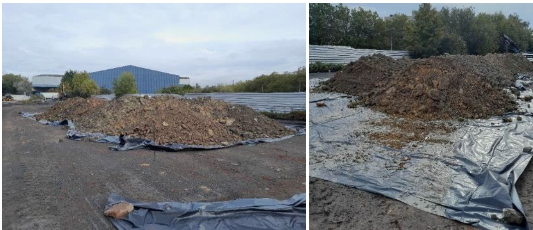
Figure 24 : Photographies de la zone de stockage de l'ensemble des terres polluées de la zone S6
