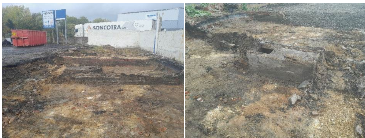
Figure 31 : Photographies du terrassement de la zone polluée X1 et de la fosse bétonnée
