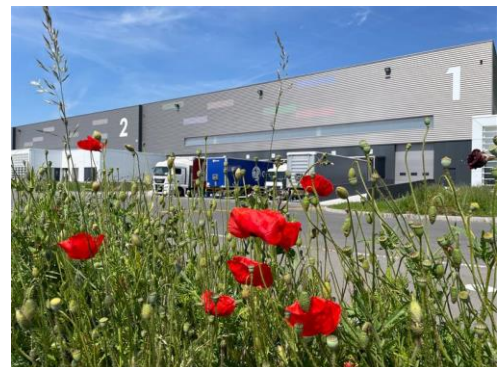
Bâtiment de 18 000 m 2 au port de Santes
